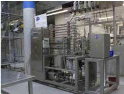
Buizen en platen UHT/pasteur
